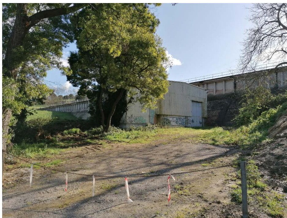
Fotografía 2. Vista exterior del edificio de cámara de válvulas.
