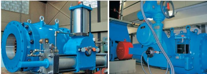
*Una válvula de paso anular ERHARD de ingeniosa ingeniería de control fue instalada en la salida de la turbina secundaria durante la modernización de una central eléctrica del río Danubio. La válvula funciona de forma autónoma a través de su propio control del medio y si las turbinas se cierran, evita los picos de presión y por lo tanto el riesgo para la planta.*
