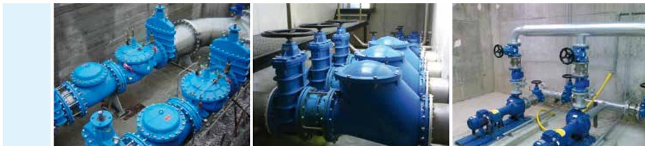
Las válvulas de compuerta de cierre elástico BV-05-47 de BELGICAST se pueden instalar tanto en redes de distribución de agua potable, como en plantas de tratamiento de aguas, así como en sistemas de regadío, bombeos,....
