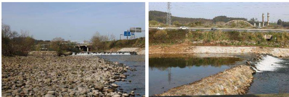
Imágenes 18 y 19. Autovía A-8 a su paso a la altura del Azud de La Lechera
