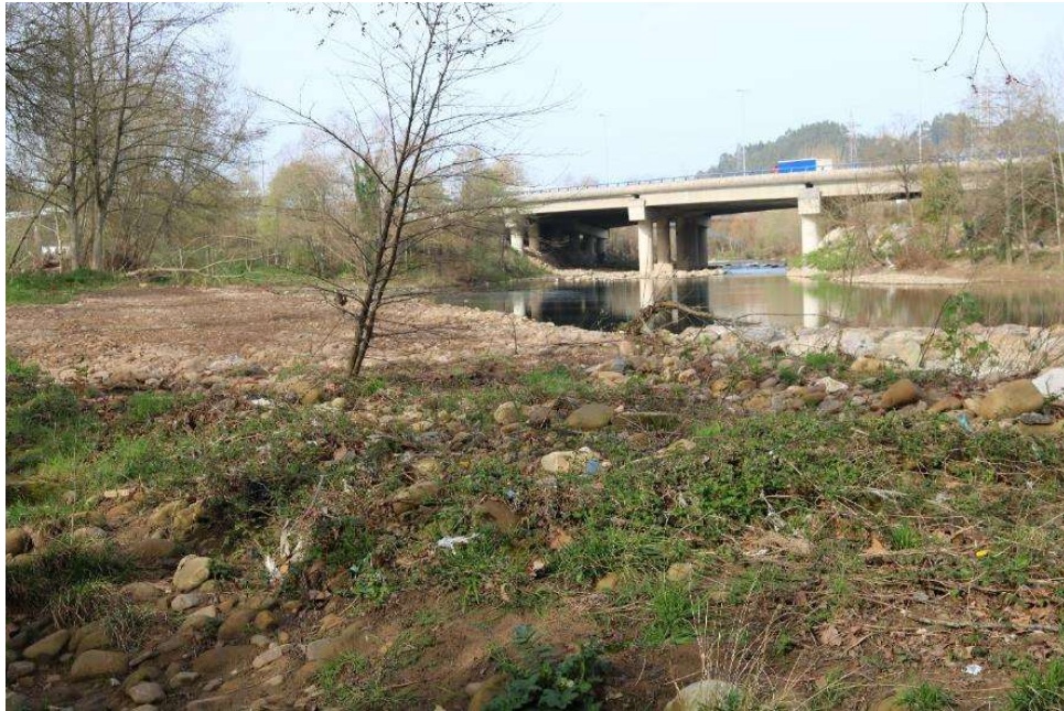
Imagen 56: Visual del emplazamiento y del entorno del azud aguas arriba
