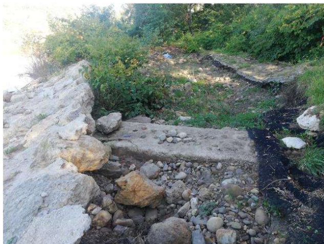
Imagen 4. Margen derecha del azud; abril de 2014.
