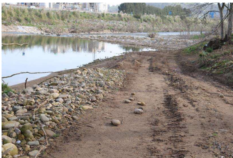
Imagen 59: Caminos de acceso existentes al azud
