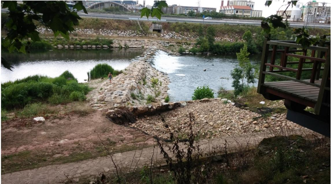
El azud-obstáculo presenta una sección trapezoidal con ambos paramentos inclinados, mayor hacia aguas abajo, y está realizado en escollera hormigonada. Su estado de conservación conjunto en general es bueno, pese a una cierta vulnerabilidad ante riadas, y presenta una coronación de forma irregular en la mitad izquierda y más uniforme y de cota más elevada en su margen derecha. Está muy colmatado en su trasdós.
