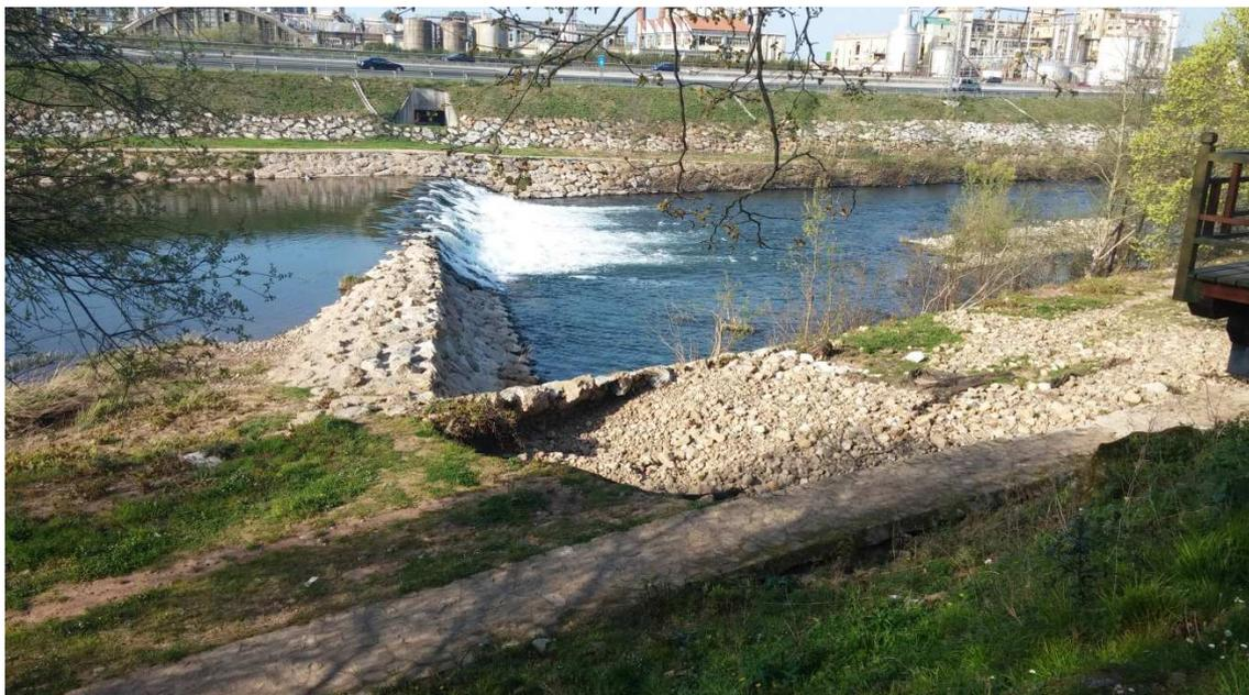
*Foto 5: Detalle azud y socavón existente*
