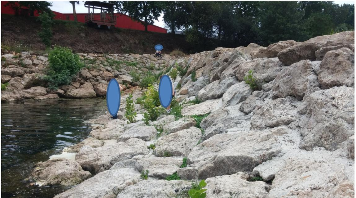
Posee una altura media sobre cimientos en torno a 2,20 metros y presenta una planta rectilínea con un cierto esvaje y con una longitud de unos 70 metros. La diferencia de cota entre aguas arriba y abajo del azud, altura útil del salto que los peces deben remontar, es alrededor de metro ochenta (1,80) en su margen izquierda y superior en la derecha, incluso por encima de los dos metros y medio.
