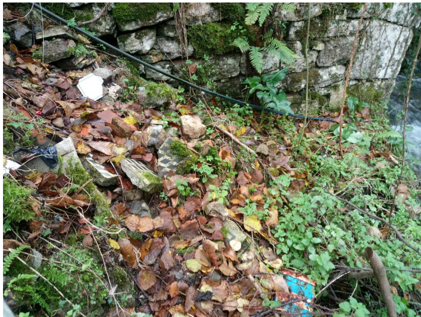
Residuos de construcción... e incluso lata de pintura.
