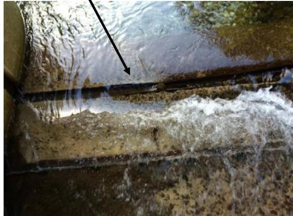
*Detalle del cierre de la compuerta sobre el azud, totalmente deformado.*
