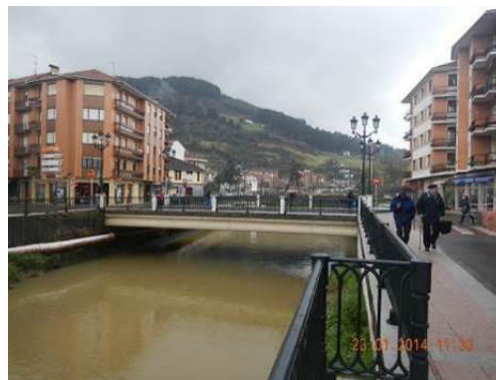
Figura 80.- Encauzamiento actual y puente de San Bartolomé
