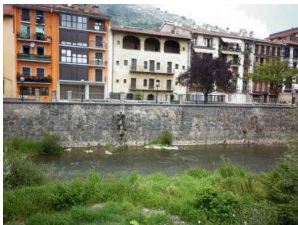
Figura 54.- Margen izquierda del río, donde se plantea como actuación la ampliación del cauce en 5 m en un muro donde posiblemente nidifique el avión zapador.
