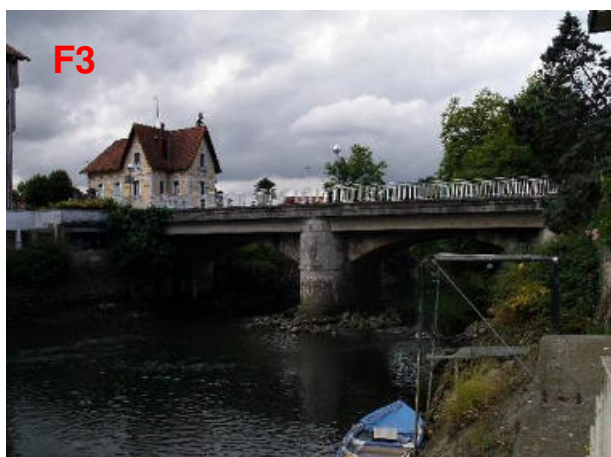
Figura 21.- Puente actual de Martutene
