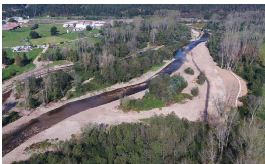
Actuaciones de adecuación y mejora del entorno del río Saja entre Ontoria y Villanueva de la Peña (TT.MM. de Cabezón de la Sal y Mazcuerras).
