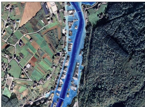
Delimitación hidráulica de la Zona Inundable (T500 años) del río Eo a su paso por Pontenova (T.M. de A Pontenova).
