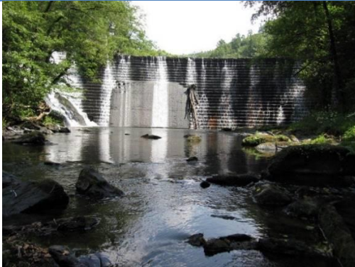
Fotografías de la presa de Inturia antes y después de su demolición. La presa tenía una altura de 12,5 metros y está ubicada en la ZEC Río Leitzaran ES2120013.
