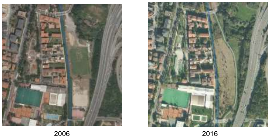
Figura 39. Evolución de los trabajos de acondicionamiento de cauce ejecutados en la cuenca del Gobelas.
