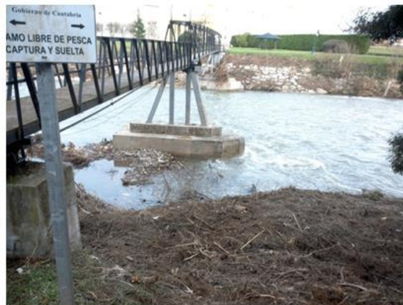
Recuperación de la sección hidráulica el Puente de Viesca (Cantabria, tras las avenidas de enero de 2019).
