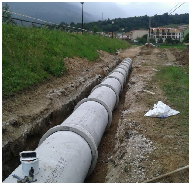
Colector de saneamiento Panes - río Deva
