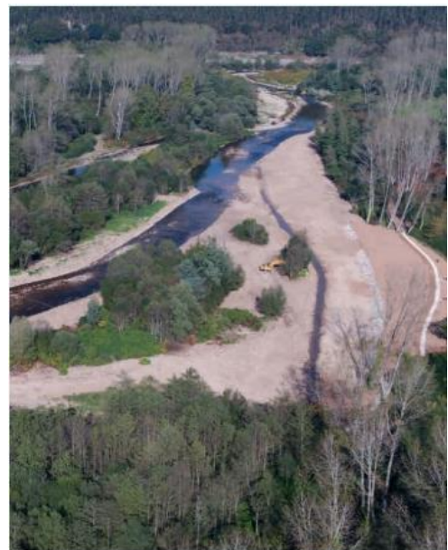
Obras de regeneración del río Saja entre Ontoria y Villanueva de la Peña
