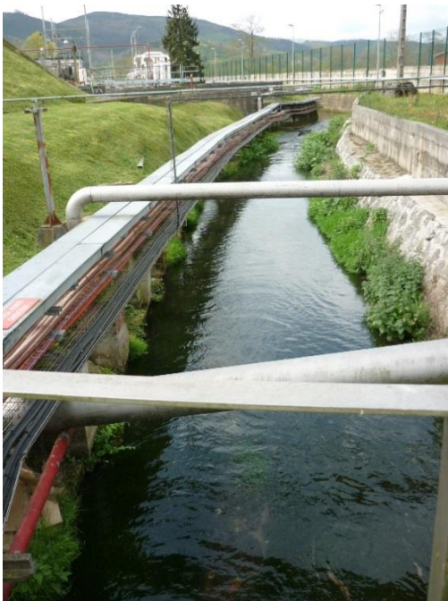
Derivación de agua para uso industrial
