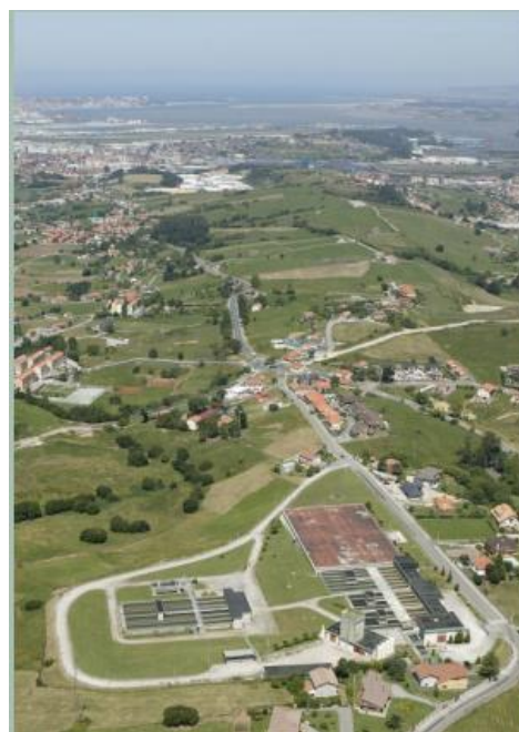
Estación de Tratamiento de Agua Potable de El Tojo (Santander)
