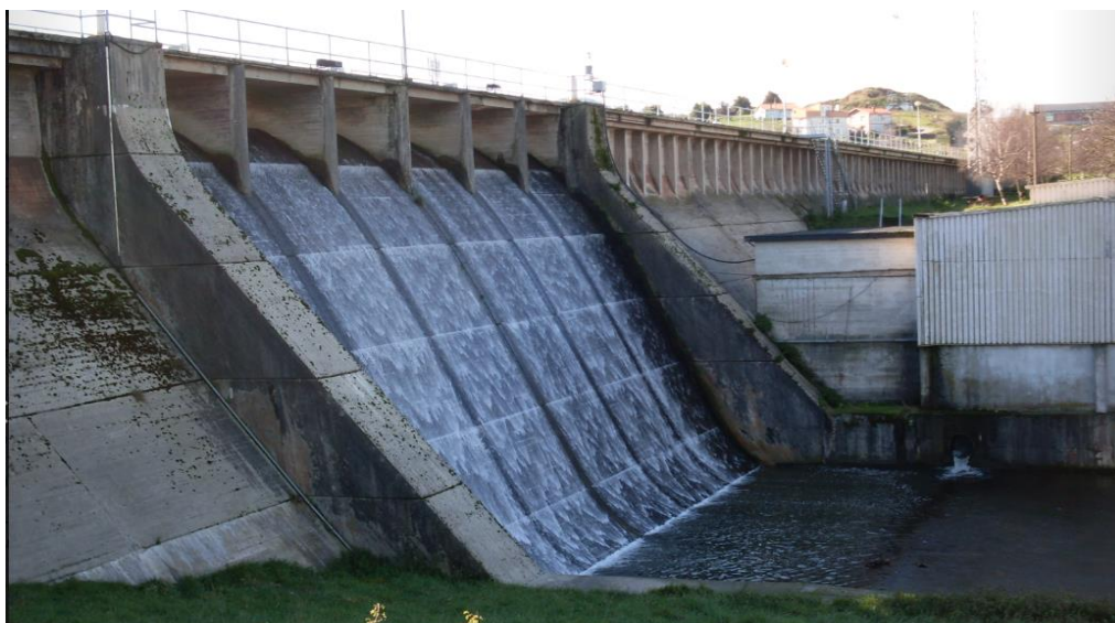
Presa de Trasona
