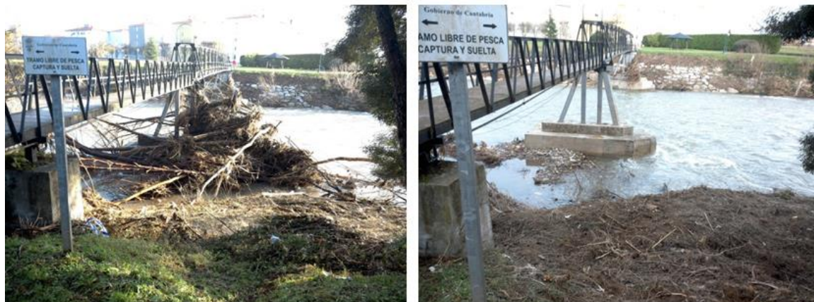
Recuperación de la sección hidráulica el Puente de Viesca (Cantabria, tras las avenida de enero de 2019).
