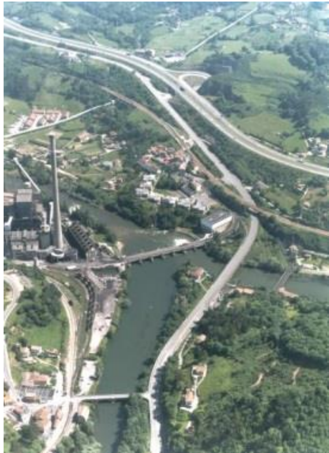
Recinto industrial entorno al río Nalón.
