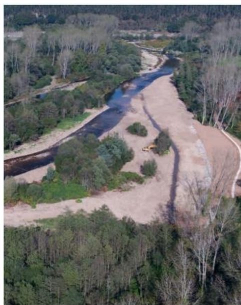
Obras de regeneración del río Saja entre Ontoria y Villanueva de la Peña
