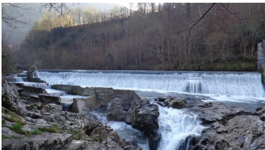
Azud de la central hidroeléctrica de Caño (río Sella)
