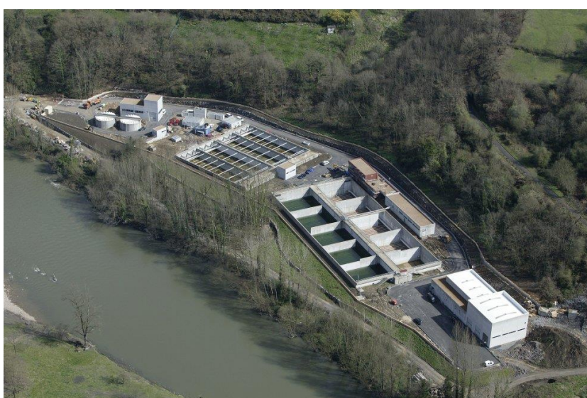
EDAR de las Caldas.
