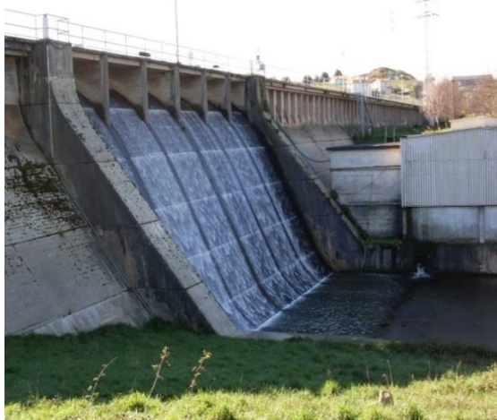
Presa de Trasona para abastecimiento industrial
