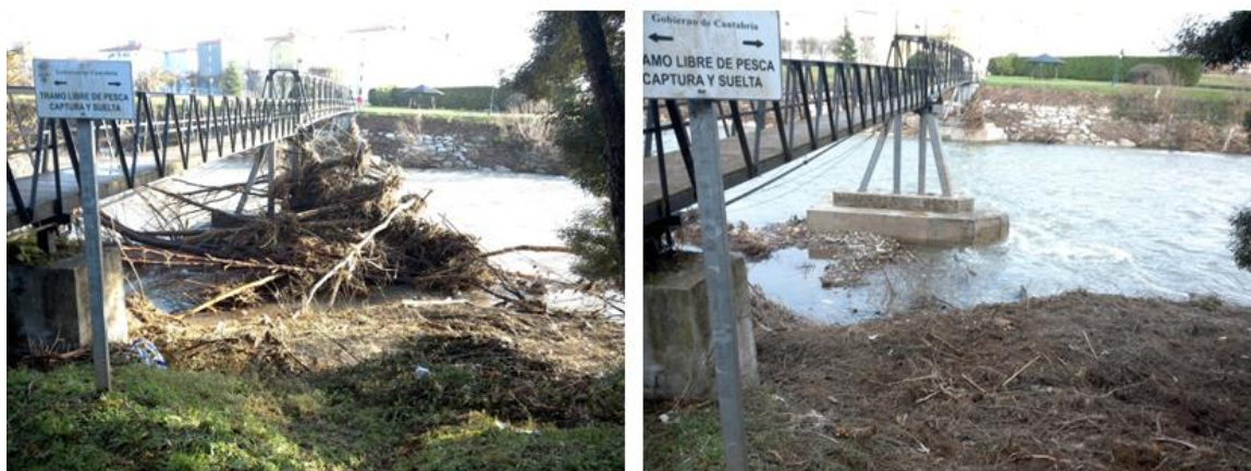
Recuperación de la sección hidráulica el Puente de Viesca (Cantabria, tras las avenidas de enero de 2019).
