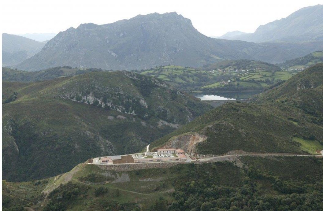
ETAP de Carbonio, Al fondo elbalse de Alfilorios, sistema de abastecimiento de Oviedo
