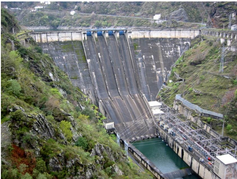
Presa de Salime – Central hidroeléctrica
