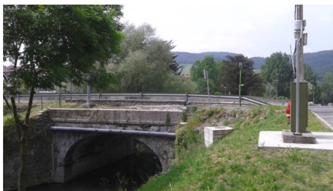
Estación de control del río Campiazo en Beranga (Cantabria).
