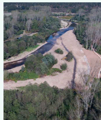
Obras de regeneración de la margen derecha y adecuación del entorno del río Saja entre Ontoria y Villanueva de la Peña (Cantabria)
