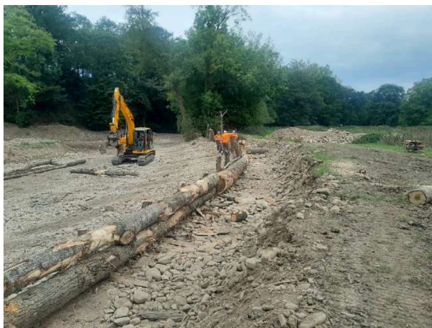
Vista general de los trabajos de reconstrucción de la bioingeniería
