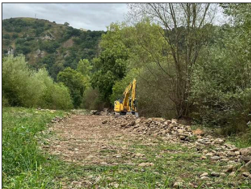
Inicio de los trabajos de restitución de la margen derecha en el punto 1 mediante el reapiado de materiales acumulados en el cauce
