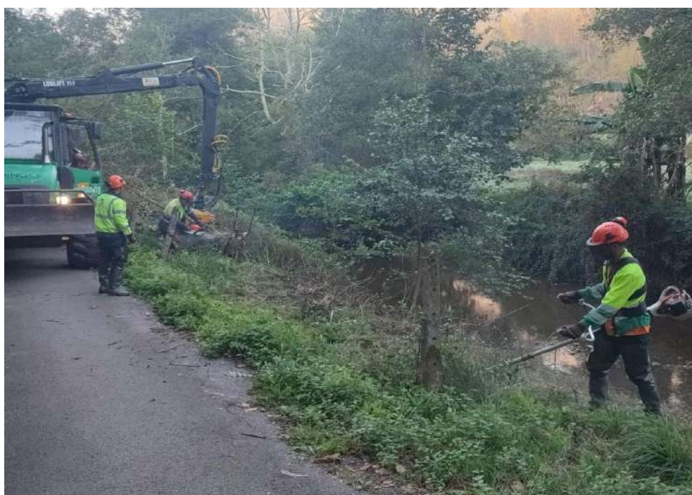
Durante los trabajos en el río España
