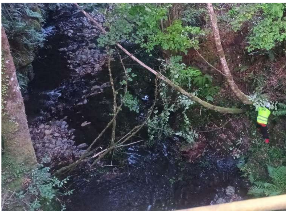
Durante los trabajos el río Balouta en Murias
