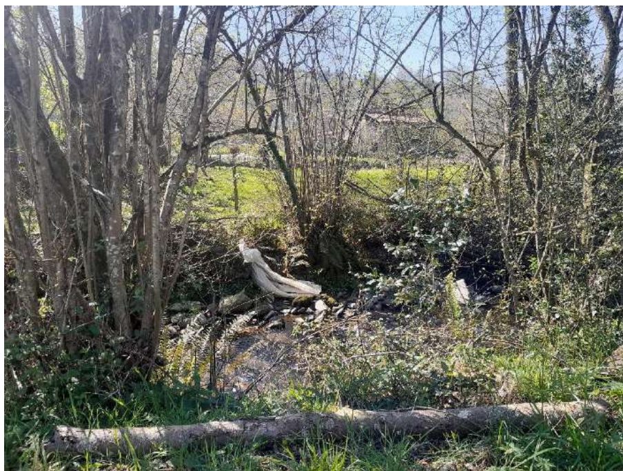
Antes de la actuación. Acumulación de restos vegetales y de restos antrópicos en el cauce del río Ruahermosa
