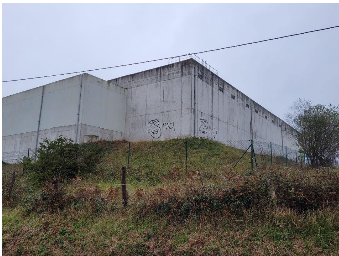
Vista general del depósito existente
