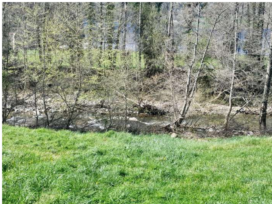
Antes de la actuación. Árbol caído en la margen del río Carranza
