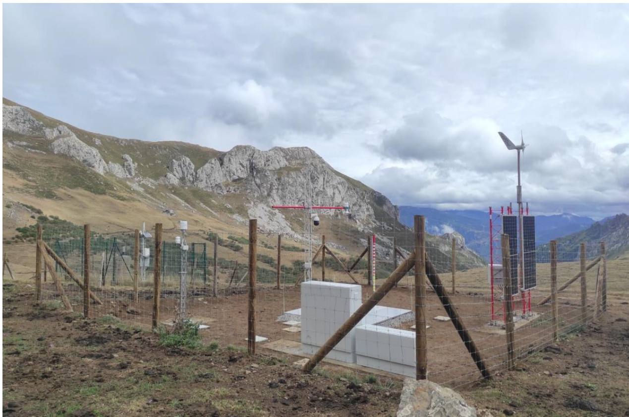
Nueva estación en el puerto de La Ballota, Lena (Asturias).
