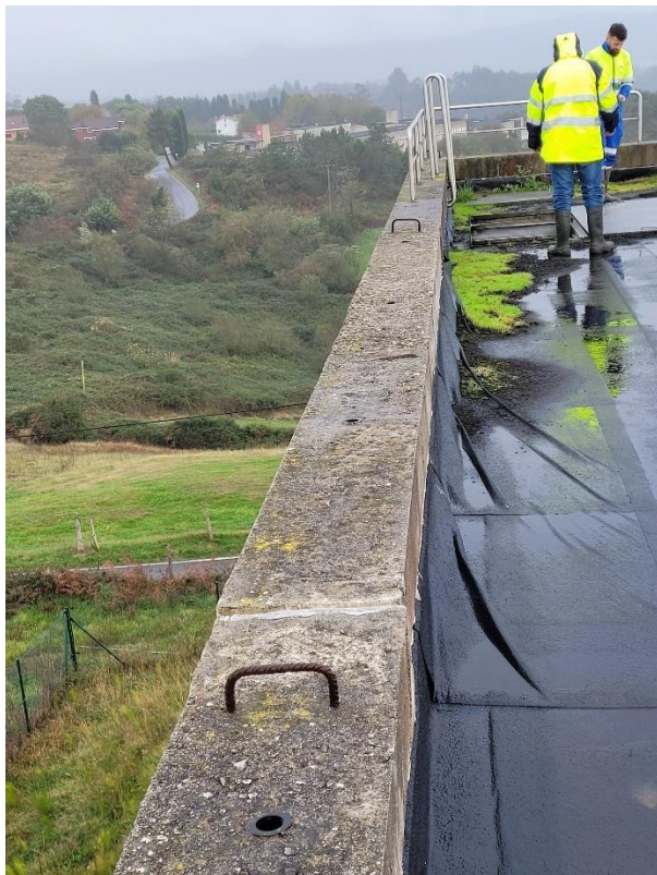
Imágenes 22 y 23.- Coronación de los muros este y sur y estado de impermeabilización de cubierta.
