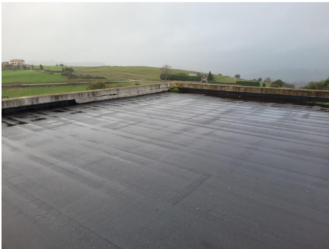
Imagen 17.- Vista de cubierta en dirección sur – norte.
