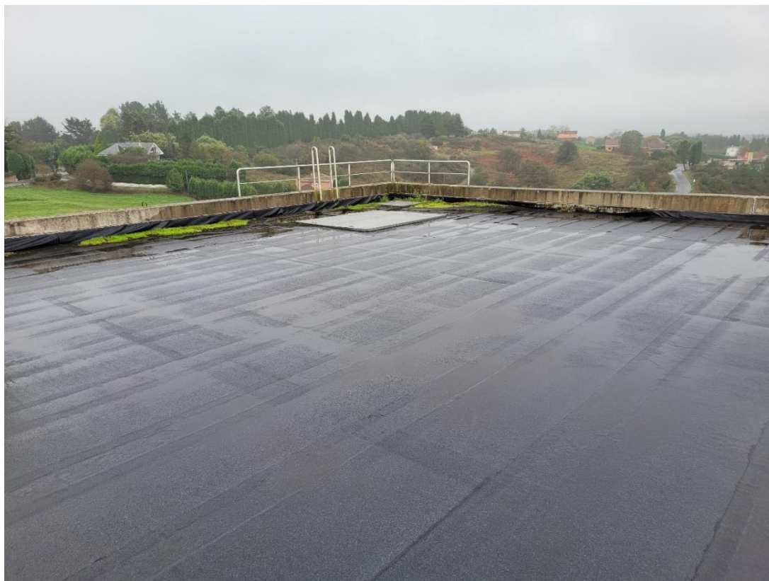
Imagen 16.- Vista de cubierta en dirección oeste – este.
