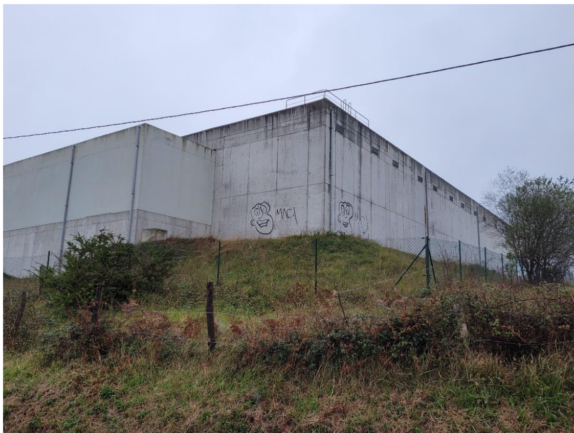
Imagen 1.- Vista general del depósito situado en terreno a media ladera y sobre un relleno.
