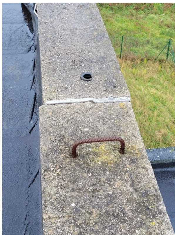
Imágenes 22 y 23.- Coronación de los muros este y sur y estado de impermeabilización de cubierta.
