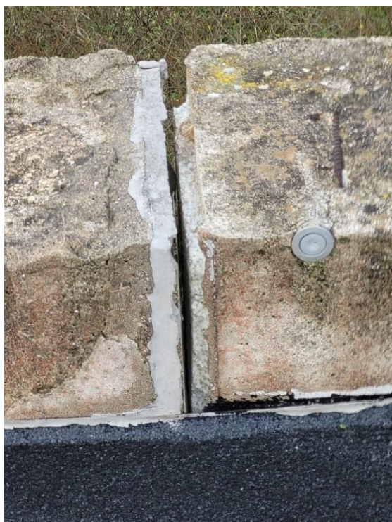
Imágenes 20 y 21.- Detalles de junta de coronación de muro con desplazamientos relativos.
