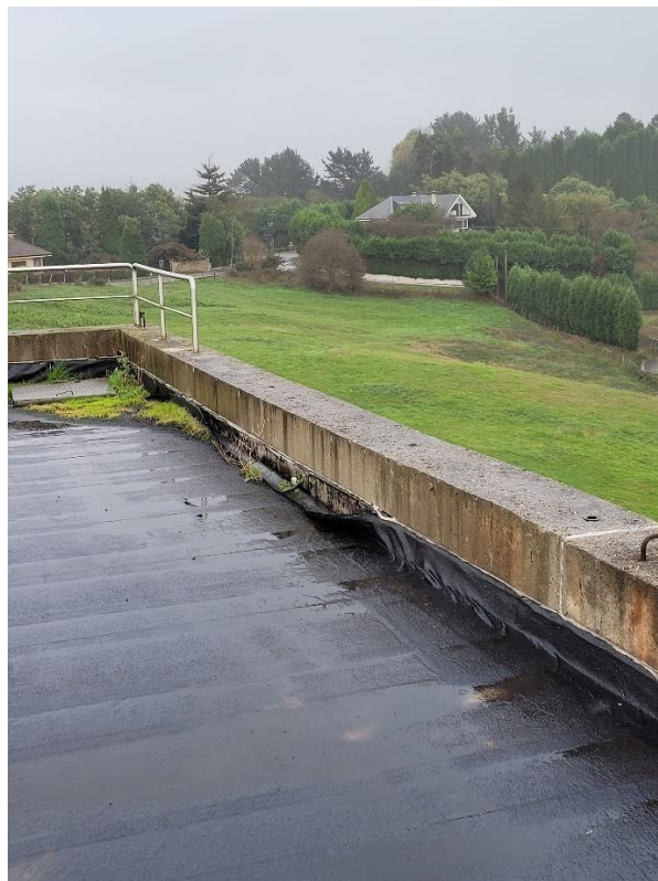
Imágenes 22 y 23.- Coronación de los muros este y sur y estado de impermeabilización de cubierta.
