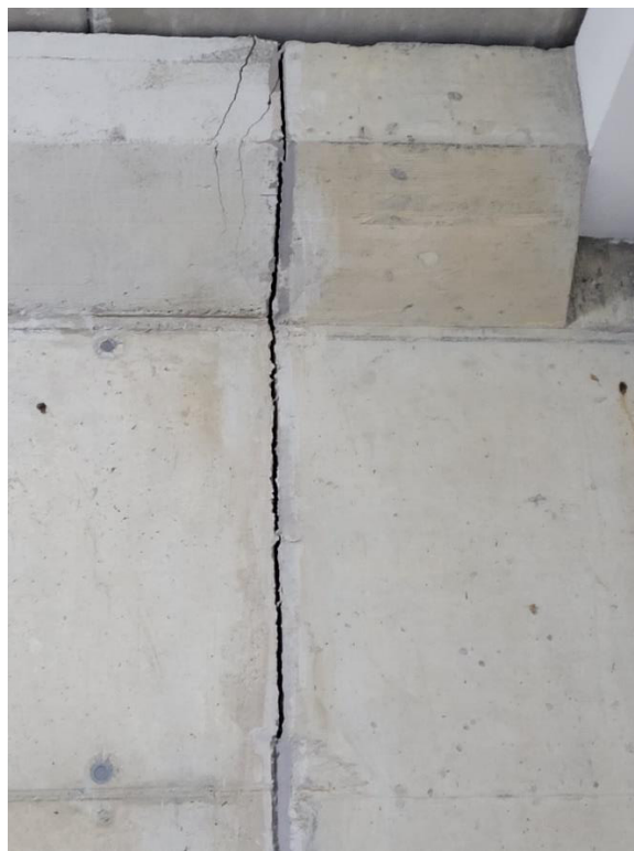
Imagen 10.- Espacio entre muro norte y ladera sin relleno.
