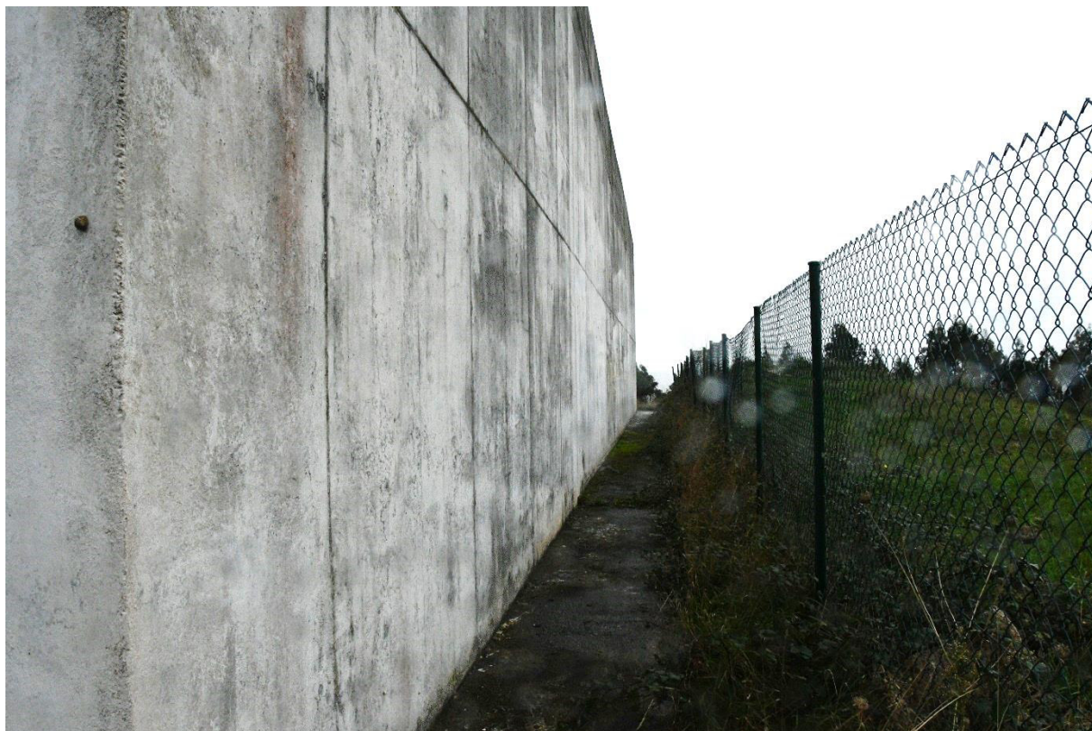
Imagen 10.- Espacio entre muro norte y ladera sin relleno.
