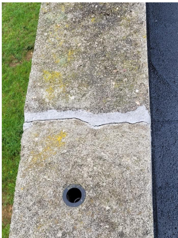
Imágenes 22 y 23.- Coronación de los muros este y sur y estado de impermeabilización de cubierta.
