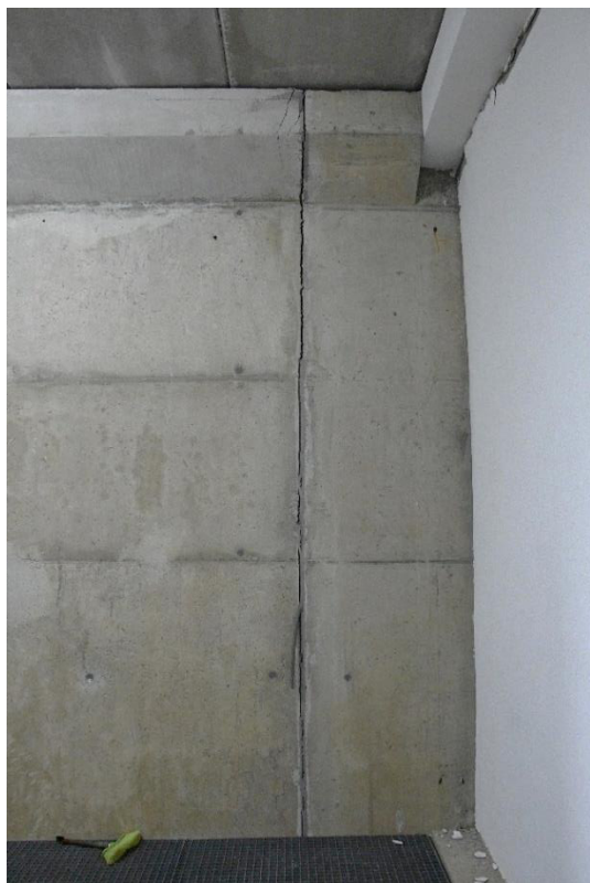
Imágenes 11 y 12.- Interior de la cámara de llaves con junta de construcción abierta.
