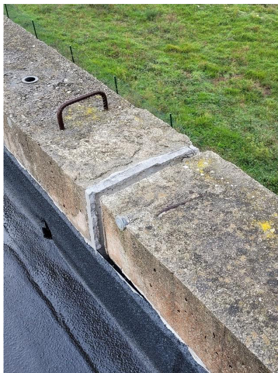
Imágenes 20 y 21.- Detalles de junta de coronación de muro con desplazamientos relativos.
