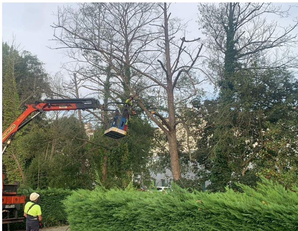
Desarrollo de los trabajos
