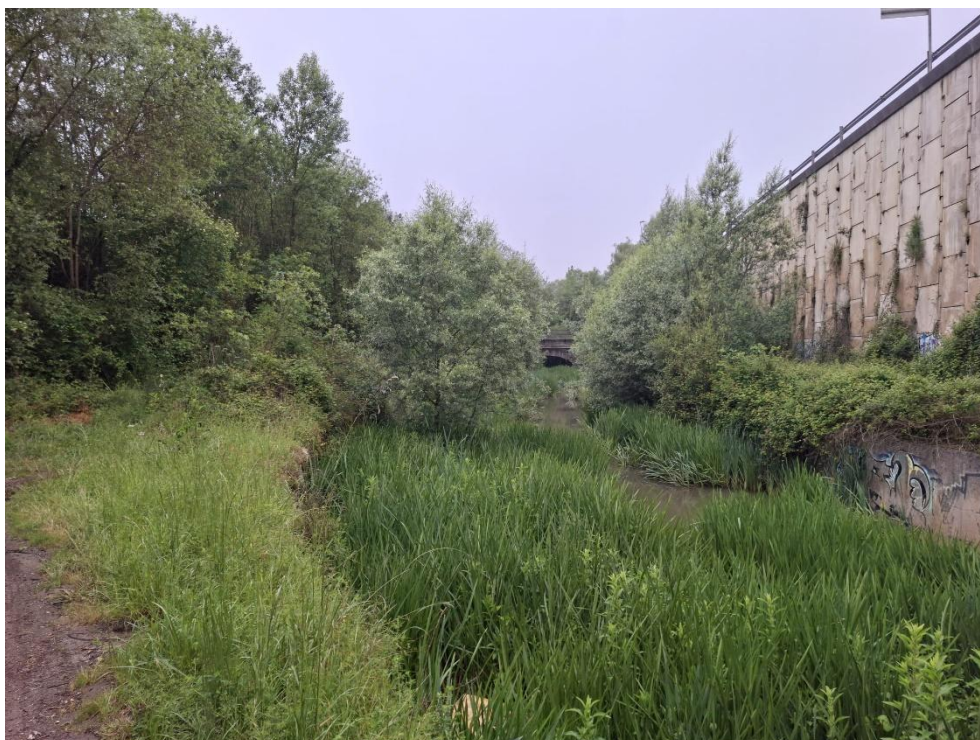
Antes de los trabajos
