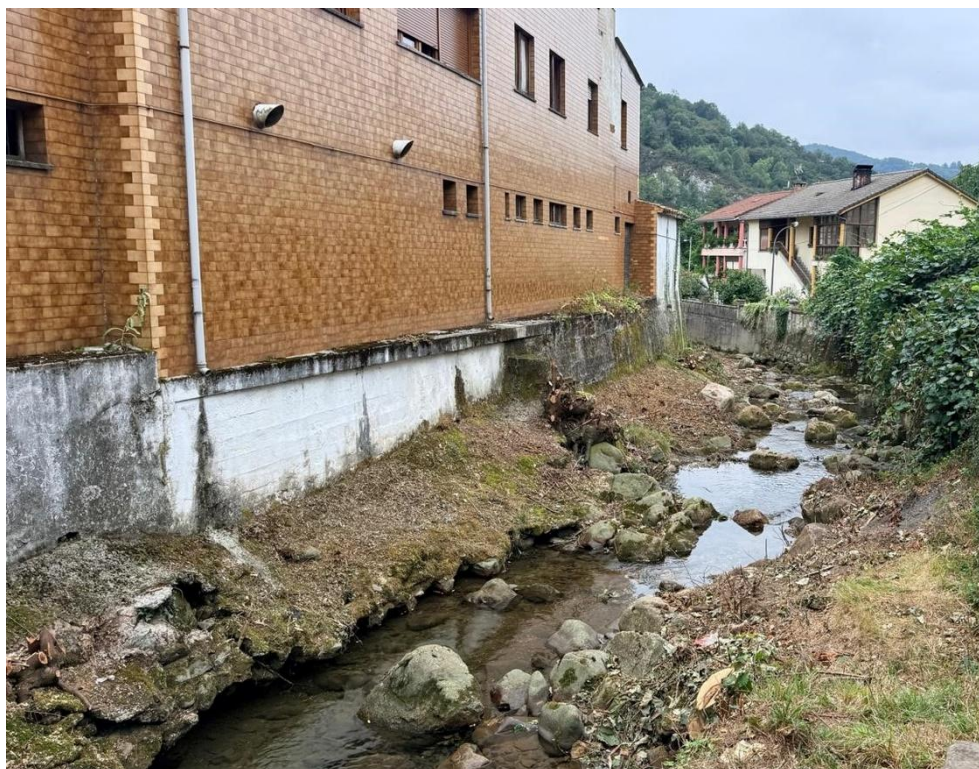
Después de los trabajos
