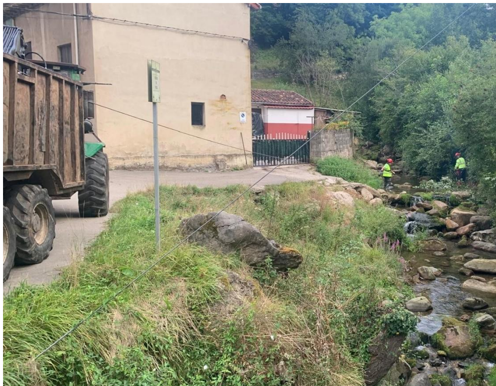
Durante los trabajos
