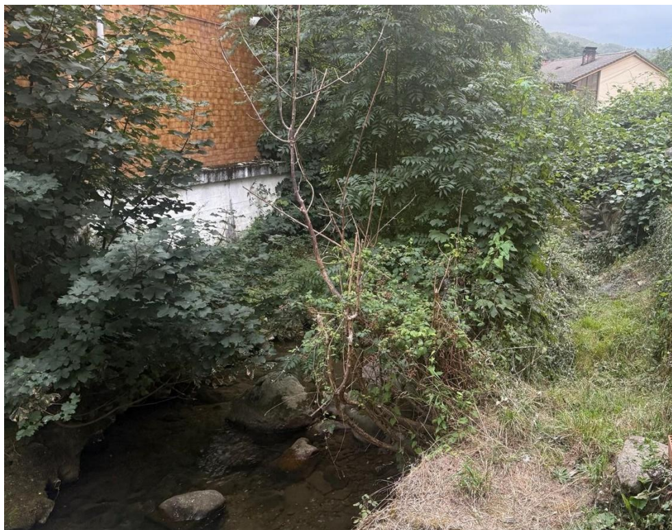
Antes de los trabajos
