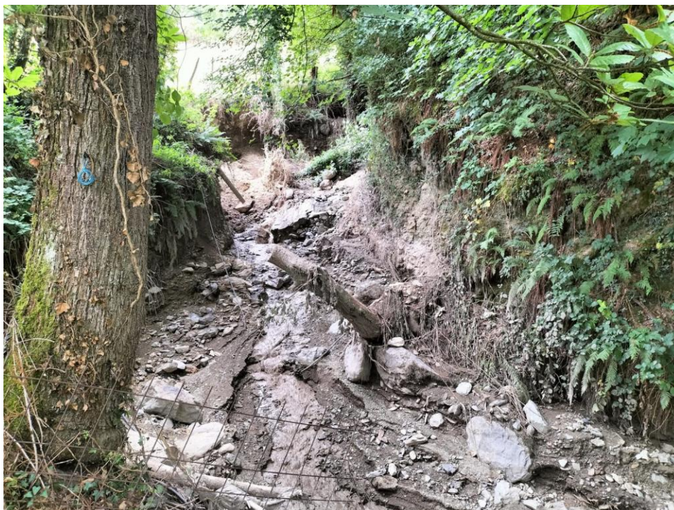
Punto 4: Antes de los trabajos
