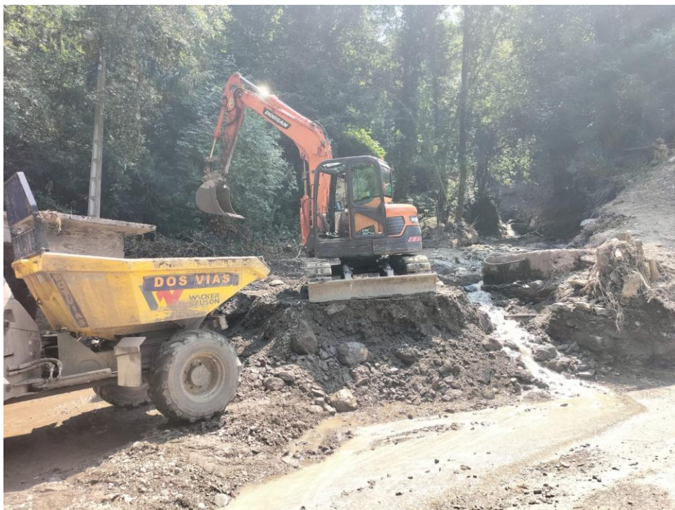
Punto 3: Comienzo de los trabajos
