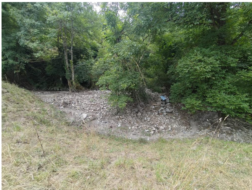
Punto 5: Antes de los trabajos
