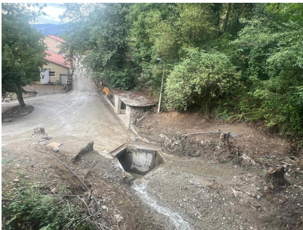
Punto 2: Finalizando los trabajos
