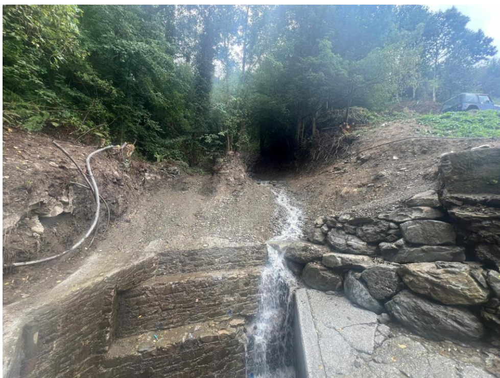
Punto 3: Fin de los trabajos
