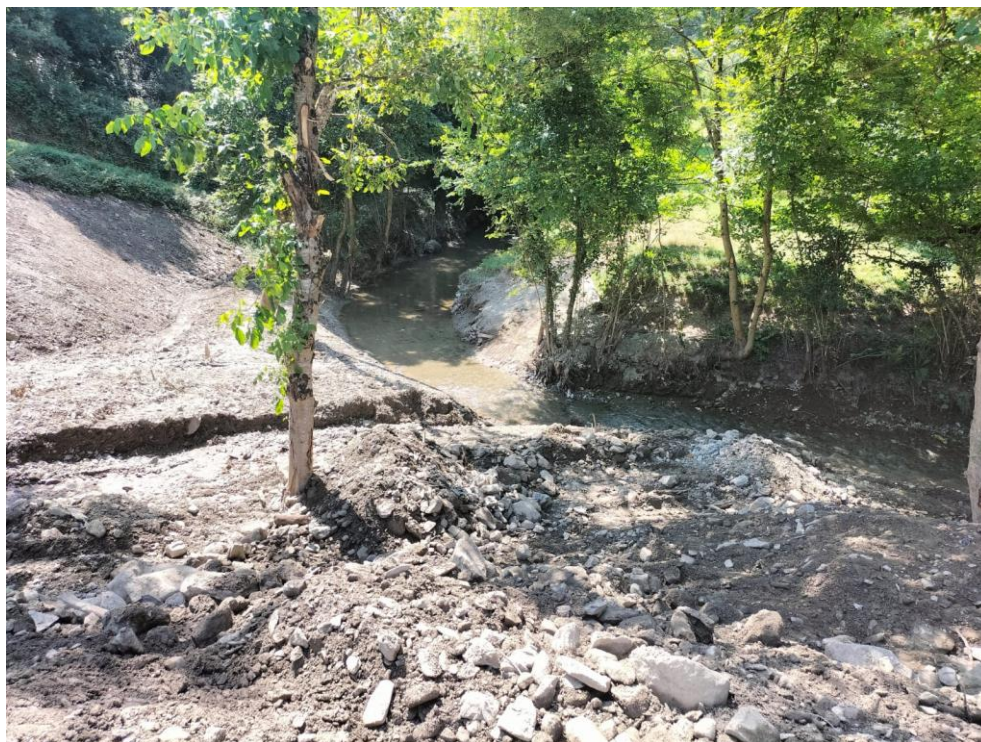
Punto 5: Después de los trabajos
