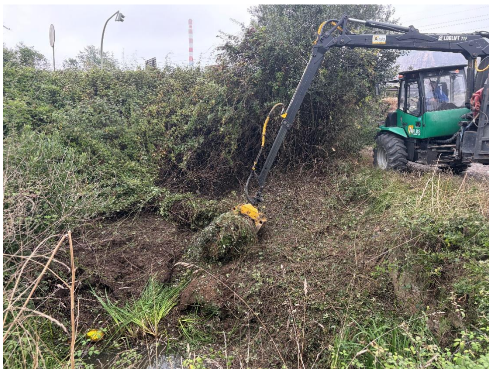
Durante los trabajos
