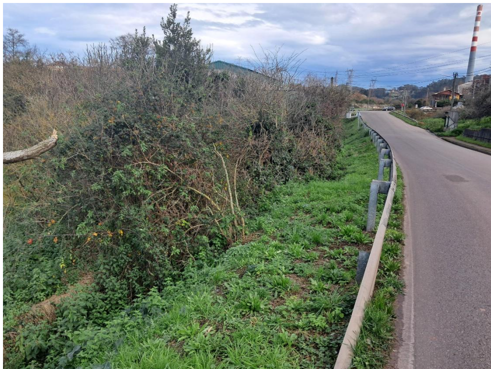
Antes de los trabajos
