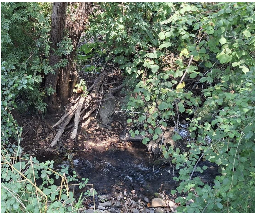
Antes de los trabajos
