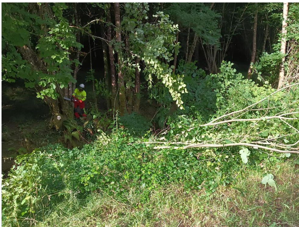
Durante los trabajos
