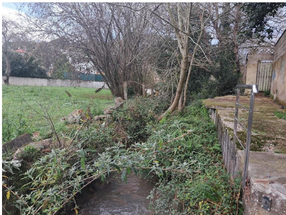
Antes de los trabajos
