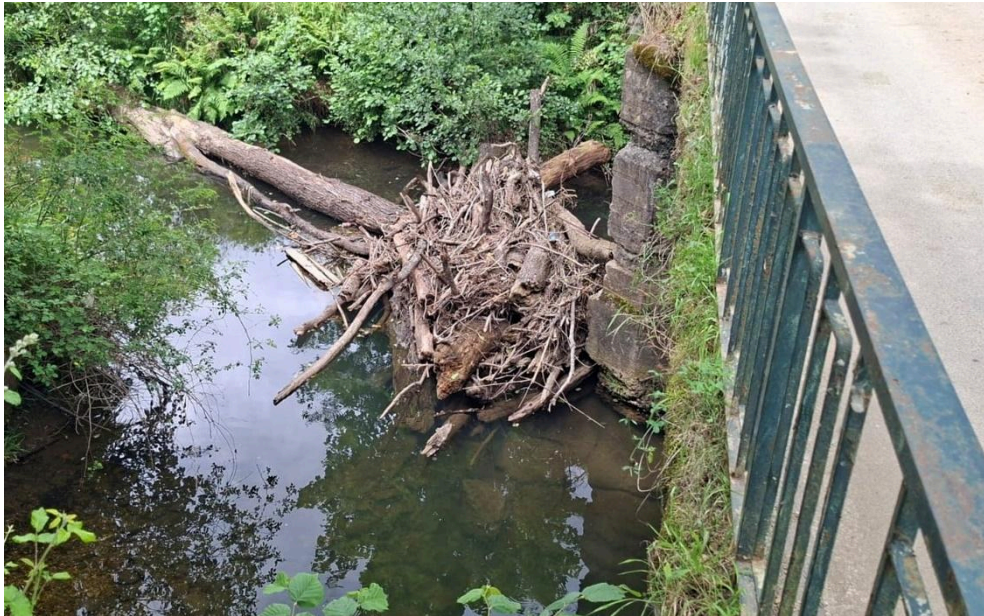
Antes de los trabajos
