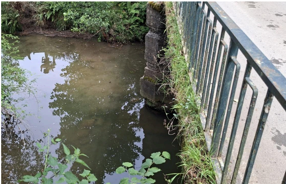
Después de los trabajos
