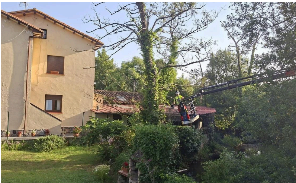
Durante los trabajos
