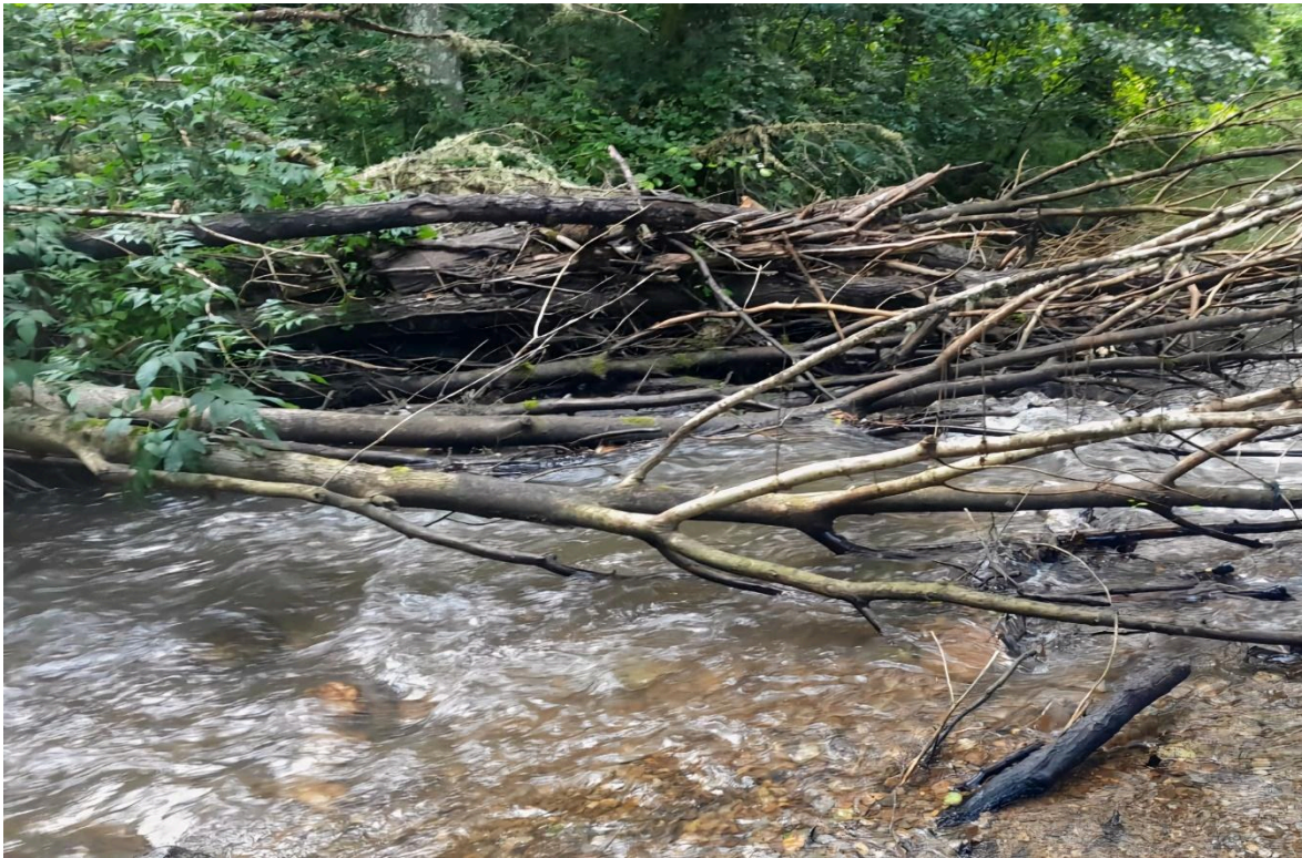
Antes de los trabajos
