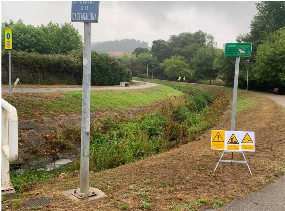
Antes de los trabajos
