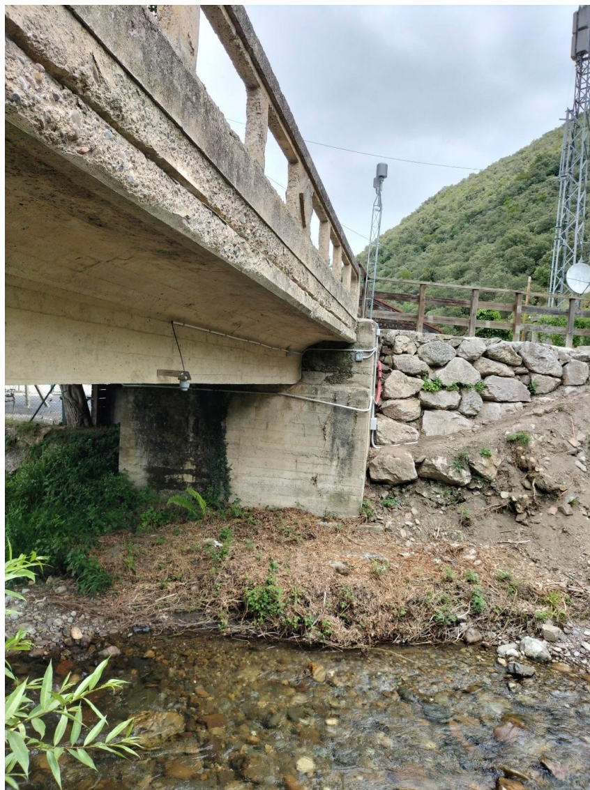
Nueva estación en el río Frío en La Vega (Cantabria)
