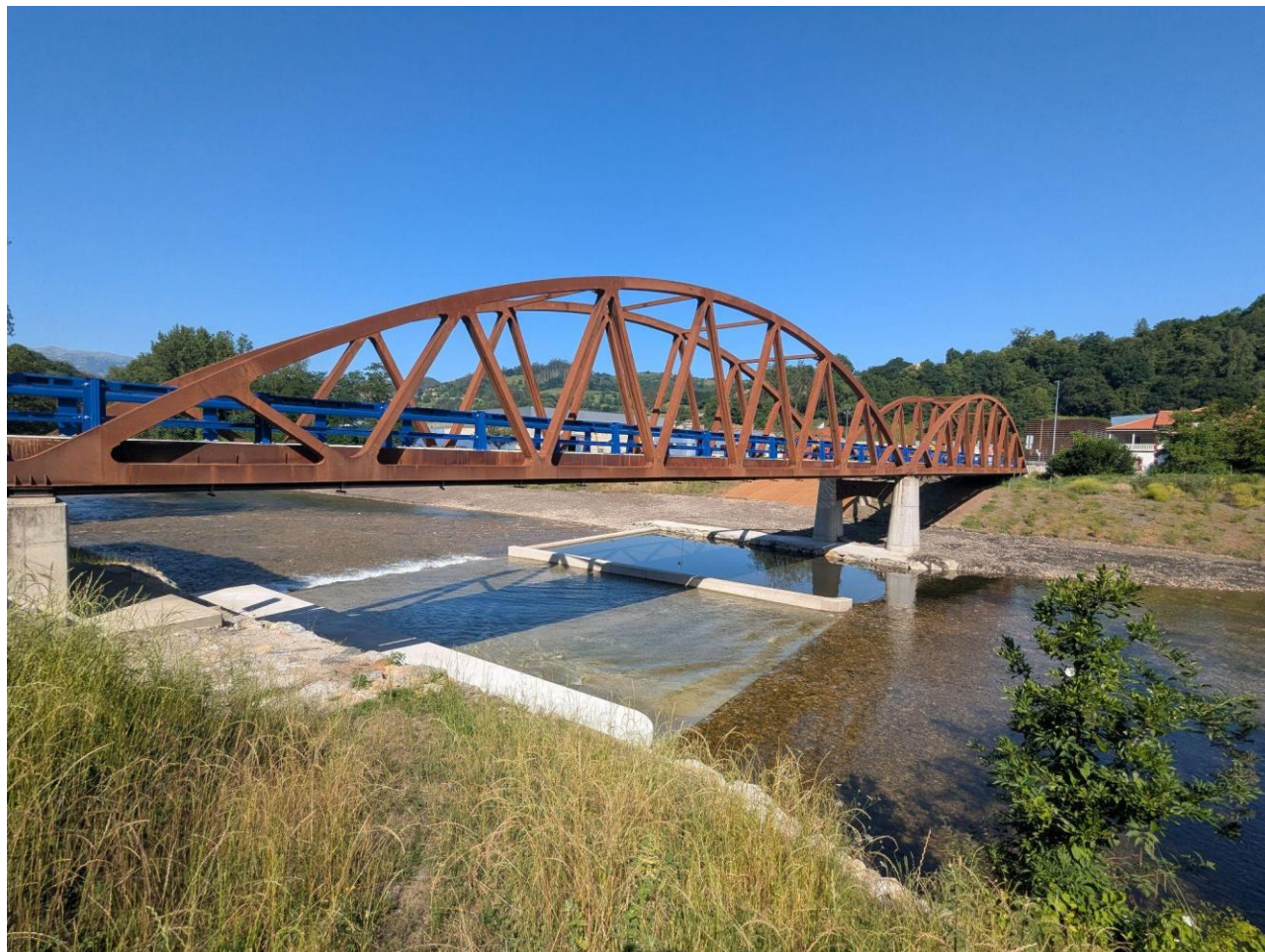
Nueva estación en el río Nalón en Olloniego (Asturias)
