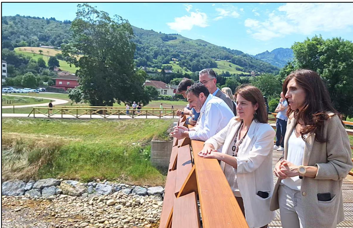
Parte de la visita a las obras del Proyecto de recuperación ambiental del río Nalón en La Chalana
