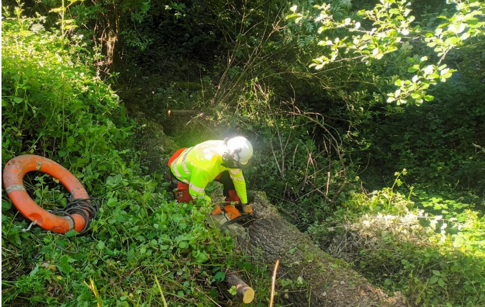
Durante los trabajos en el río Das Cales
