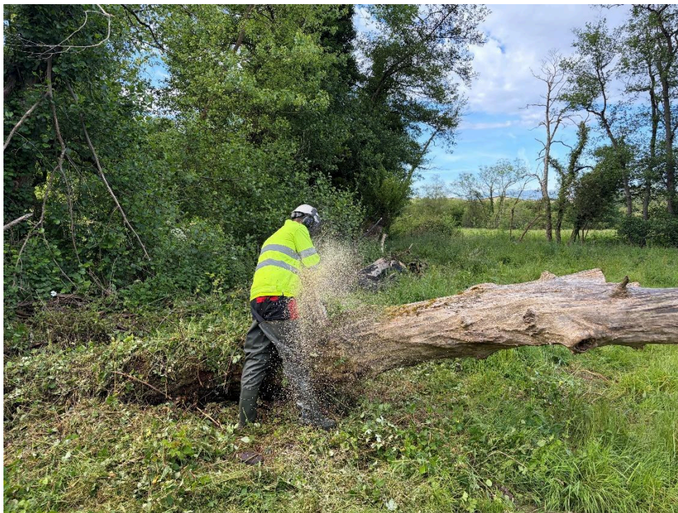
Durante los trabajos en el río Noreña en La Fresneda
