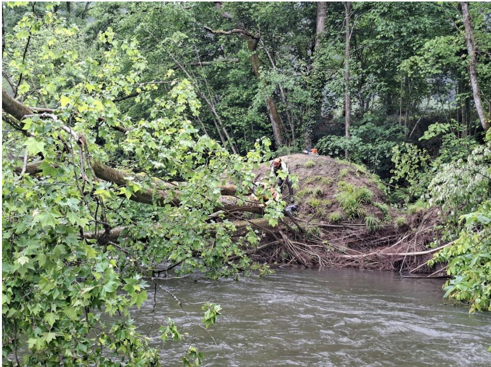
Durante los trabajos
