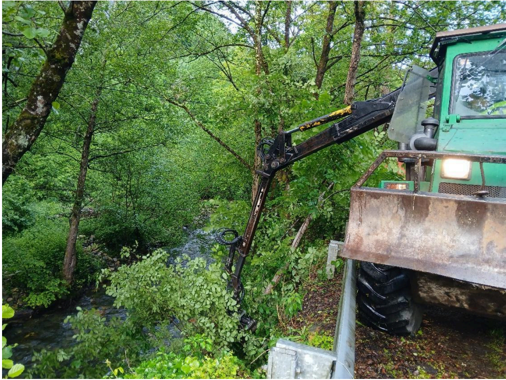
Durante los trabajos en Almurfe
