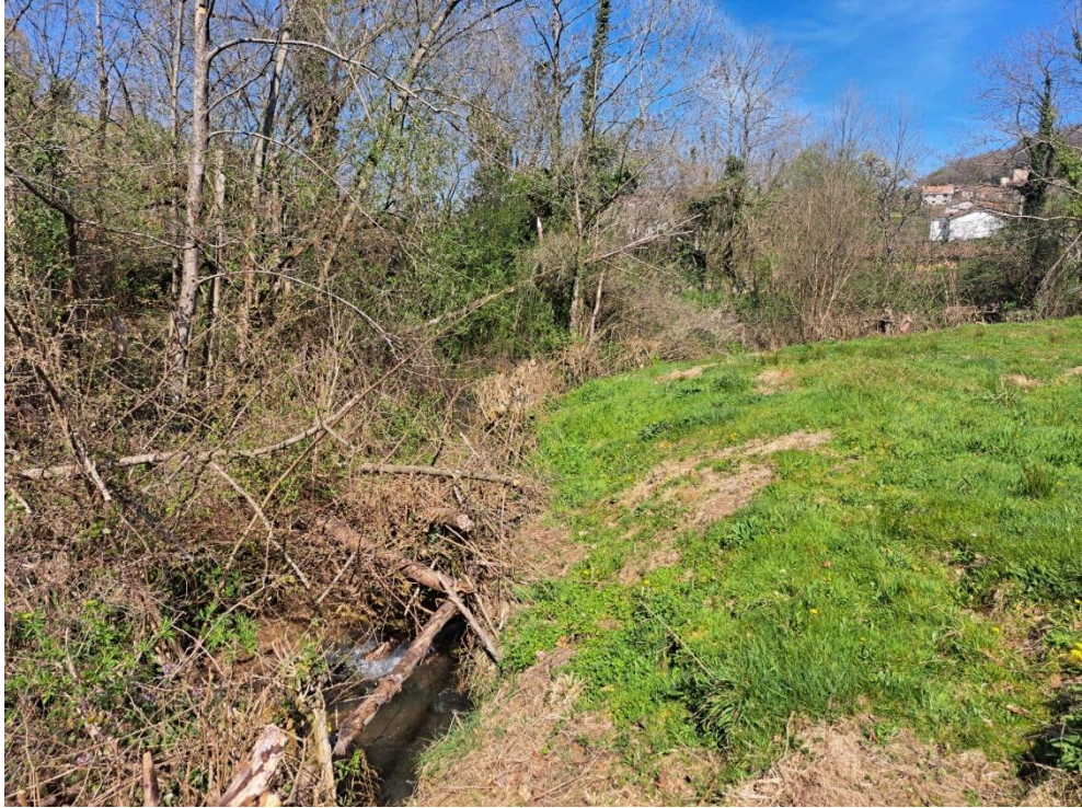
Antes de los trabajos
