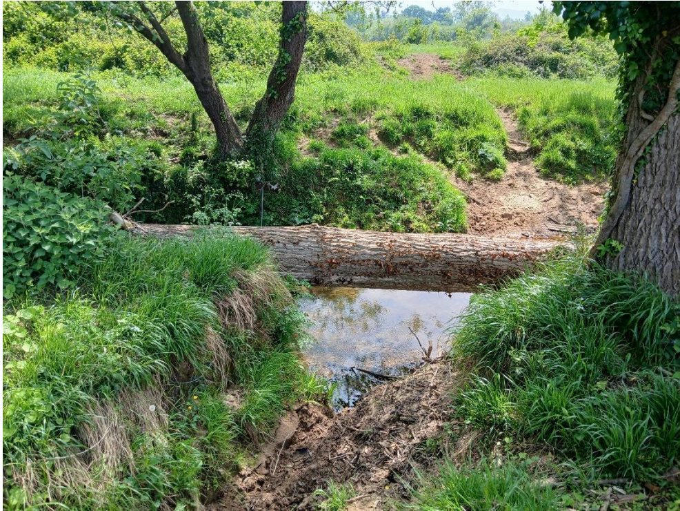
Antes de los trabajos
