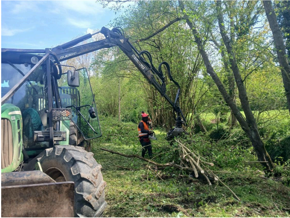
Durante los trabajos en el río Noreña en Anés
