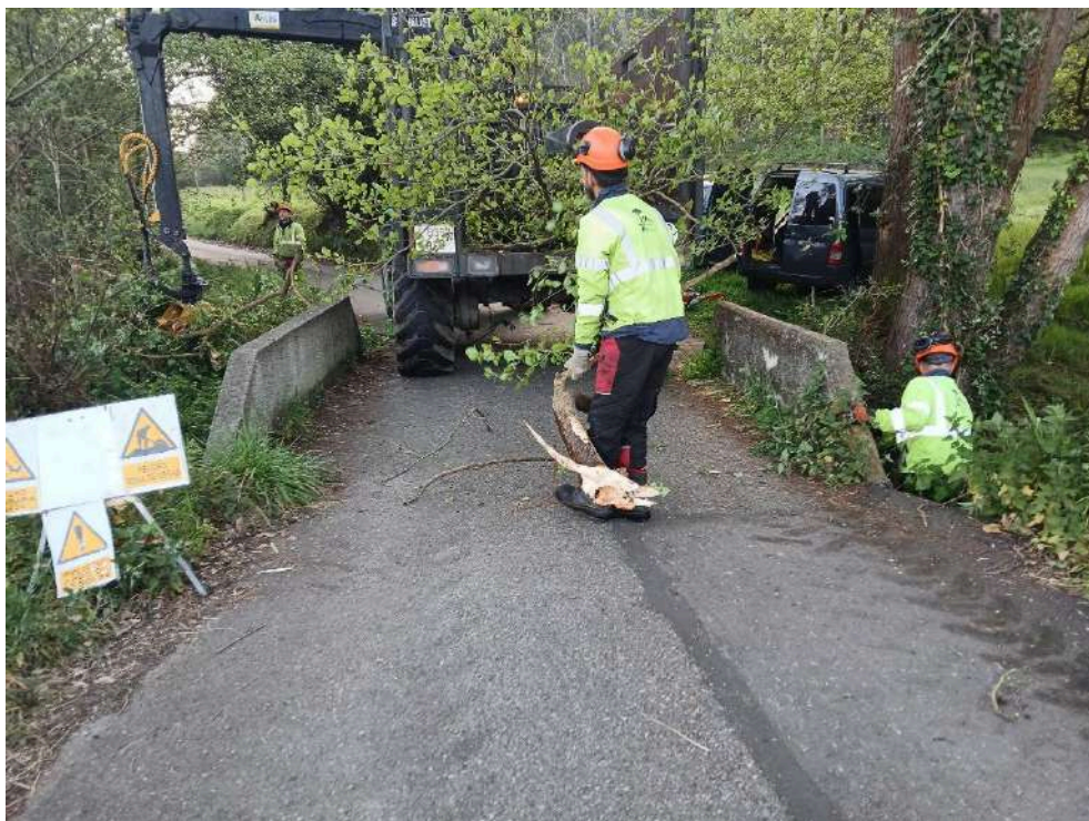
Durante los trabajos en el Arroyo Ferrota
