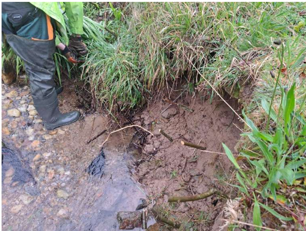
Estaquillas colocadas en margen del cauce
