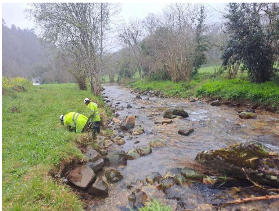
Operarios colocando estaquillas en margen del cauce
