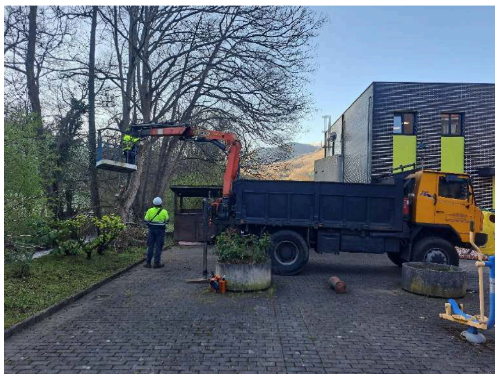
Durante los trabajos
