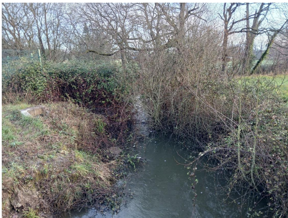
Antes de los trabajos
