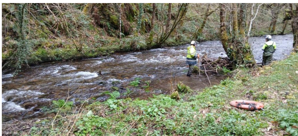
Durante los trabajos
