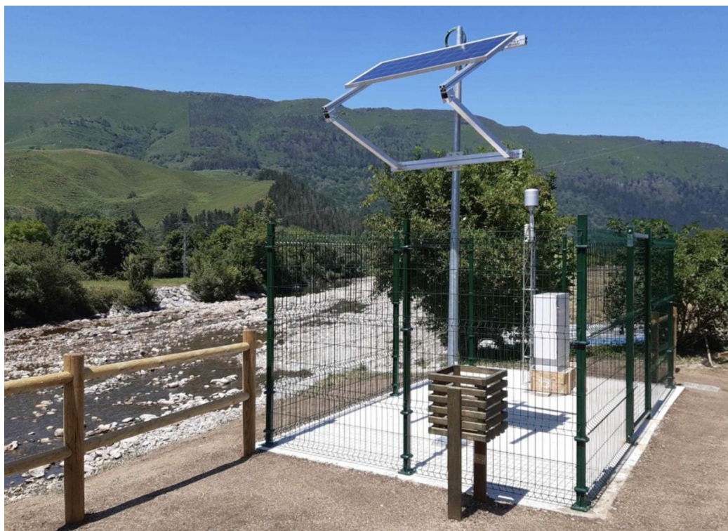
Estación del SAI CHC en el río Saja en Puente de Riente (Cantabria)
